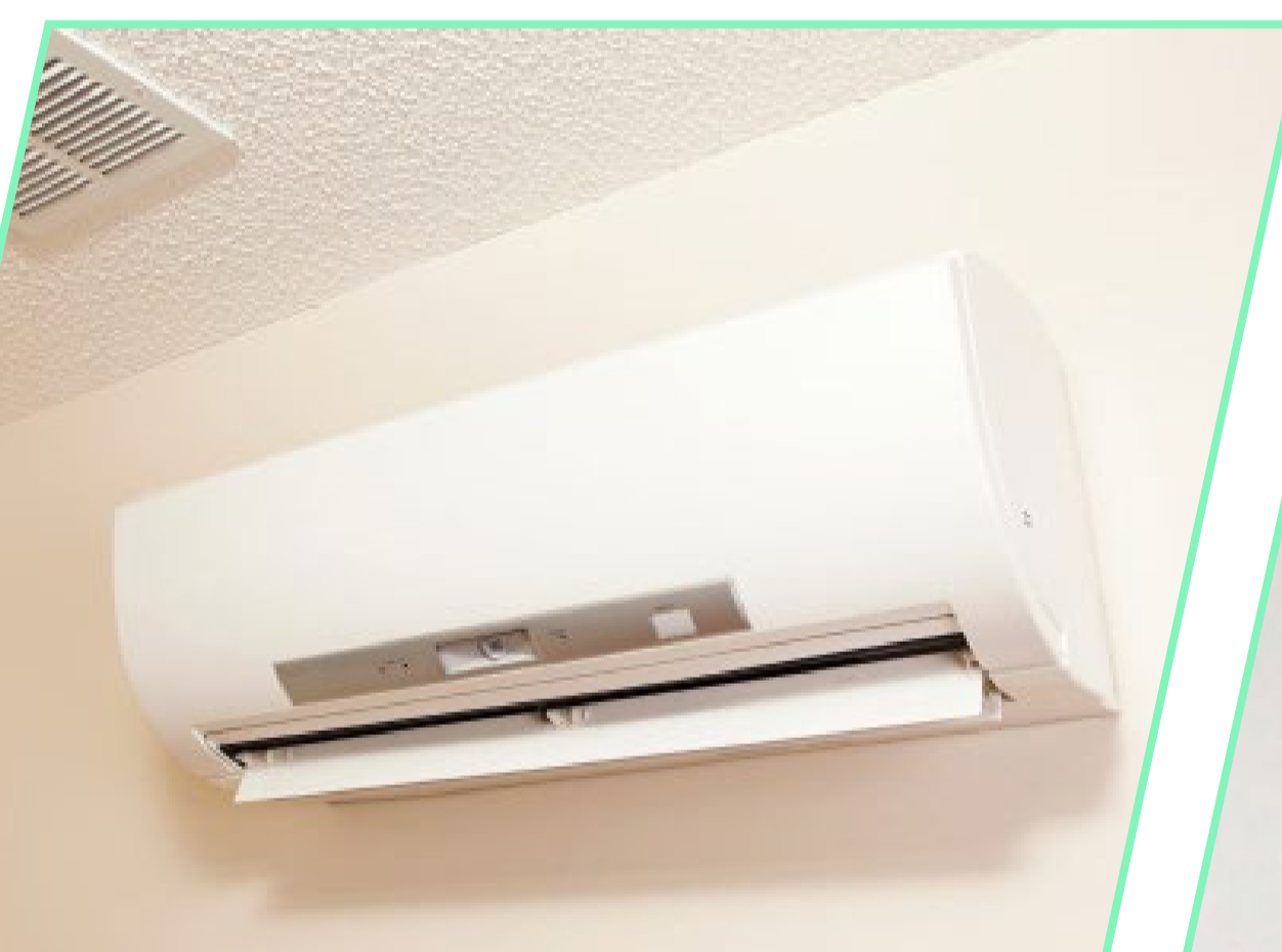
Ar-condicionado tipo split
