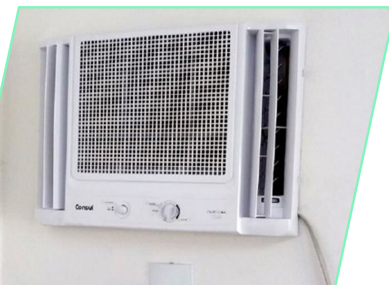
Ar-condicionado tipo de parede
